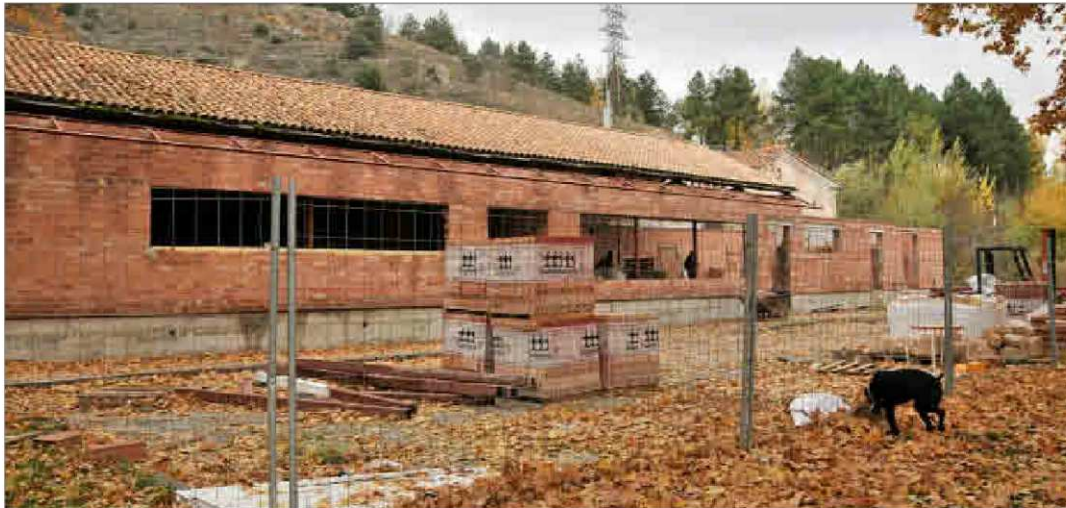
Estado ayer del que será nuevo bar restaurante en el Soto Playa. VALENTÍN GUISANDE
